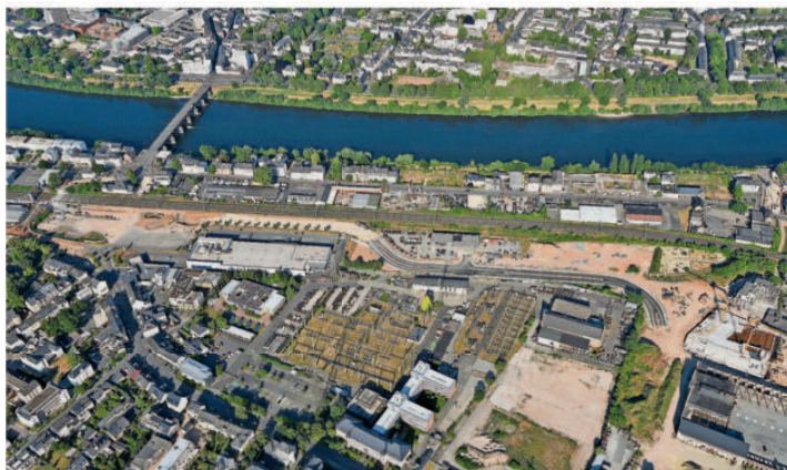
Großbaustelle Trier-West. Unter den Bauprojekten, die in diesem Jahr Priorität haben, steht der Stadtteil unter anderem mit der Entlastungsstraße ganz oben auf der Prioritätenliste der Stadt Trier.
