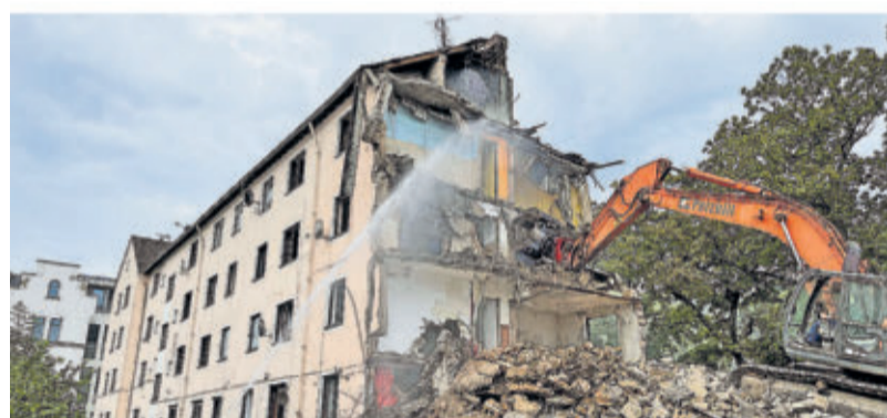
So gut wie abgeschlossen: Der Abriss des „Rosa Blocks“.
