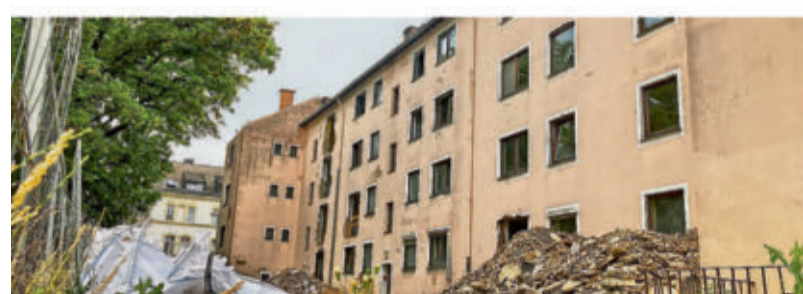
Das Gebäude soll abgerissen werden. Doch ein Schadstoff-Fund sorgt für Verzögerungen. FOTO: HARALD JANSEN
