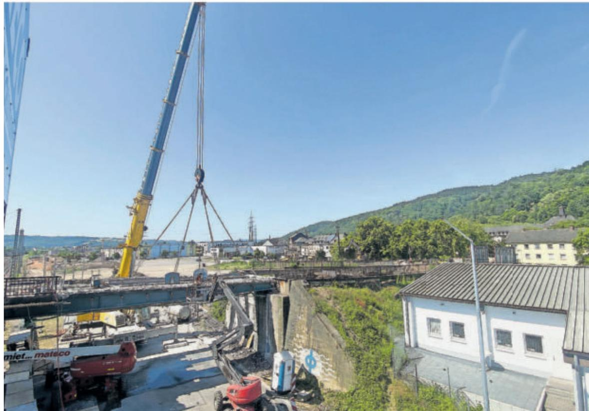
In dieser Woche wird die Betonoberschicht der Bahnbrücke in Trier-West abgerissen, nächste Woche soll die Eisenkonstruktion verschwinden.
