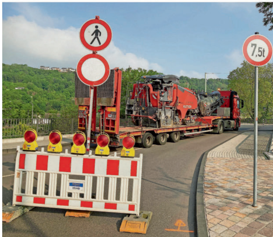
Schweres Gerät: Kurze Zeit nach der Sperrung wird eine Fräse zur Brücke gebracht, die den Oberbau der Straße zerklünnert.
