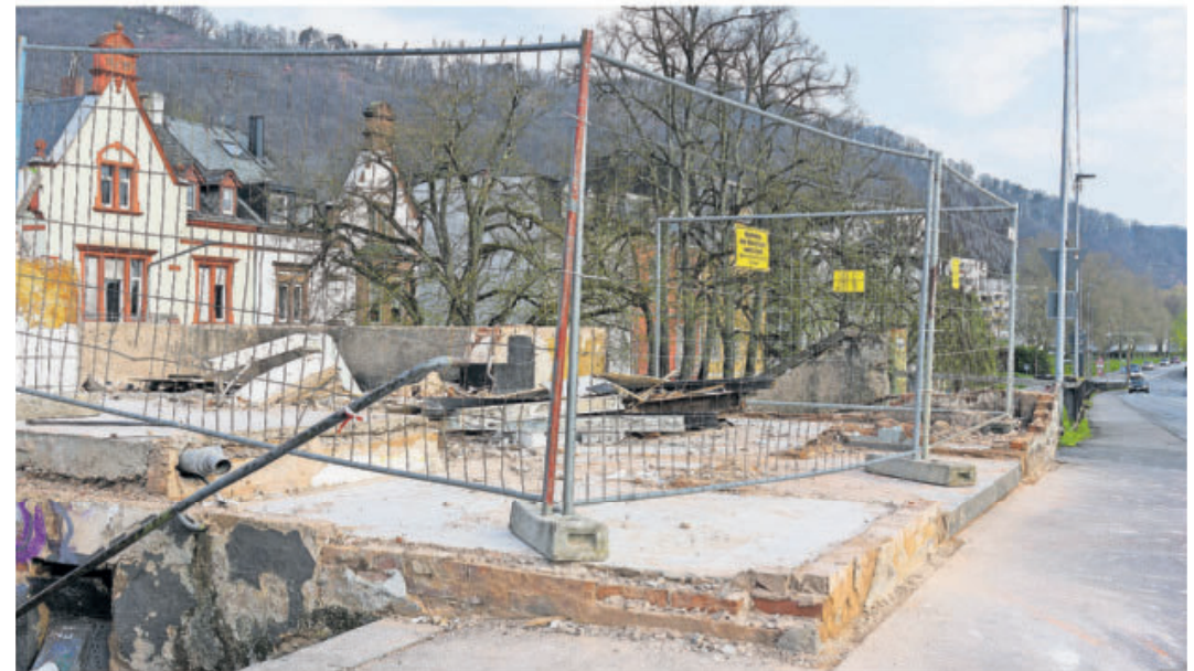
Eine schmale Treppe führt von der Trierer Hornstraße hoch zur Eisenbahnbrücke. Sie ist auch Namensgeberin für die Kult-Kneipe „Zum Treppchen“ gewesen. Jetzt wird das Gebäude wegen Umbauarbeiten an der Brücke abgerissen.
