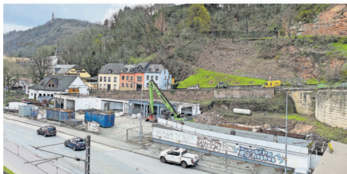
Vom ehemaligen Autohaus Buschmann in Pallien ist nicht mehr viel zu sehen. Das Gelände wird zunächst als Baustelleneinrichtung für den Haltepunkt Kaiser-Wilhelm-Brücke der Weststrecke genutzt.
