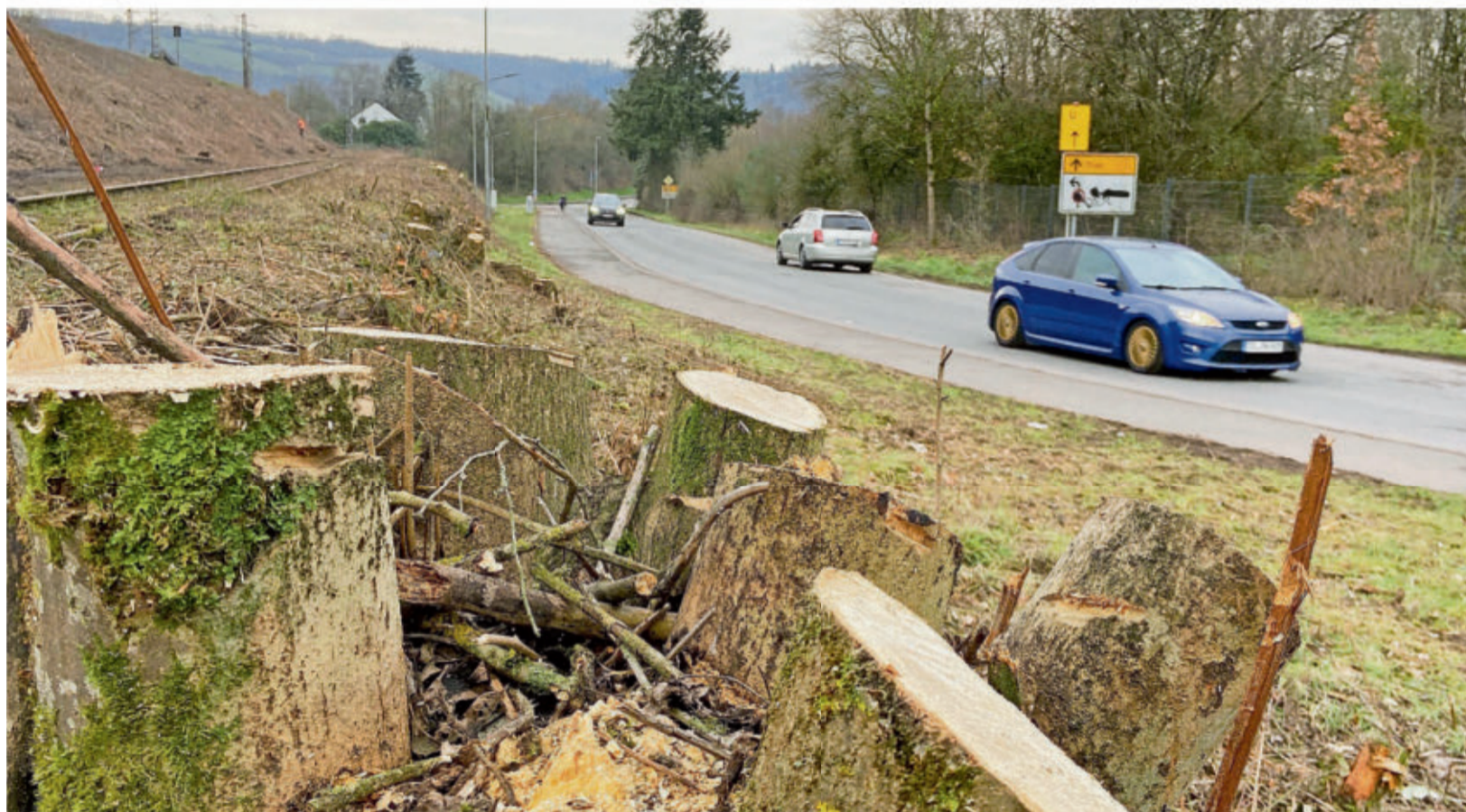
In Trier-Pfalzel sind zur Vorbereitung der nun anstehenden Bauarbeiten an der Weststrecke Bäume und Sträucher gefällt worden.
