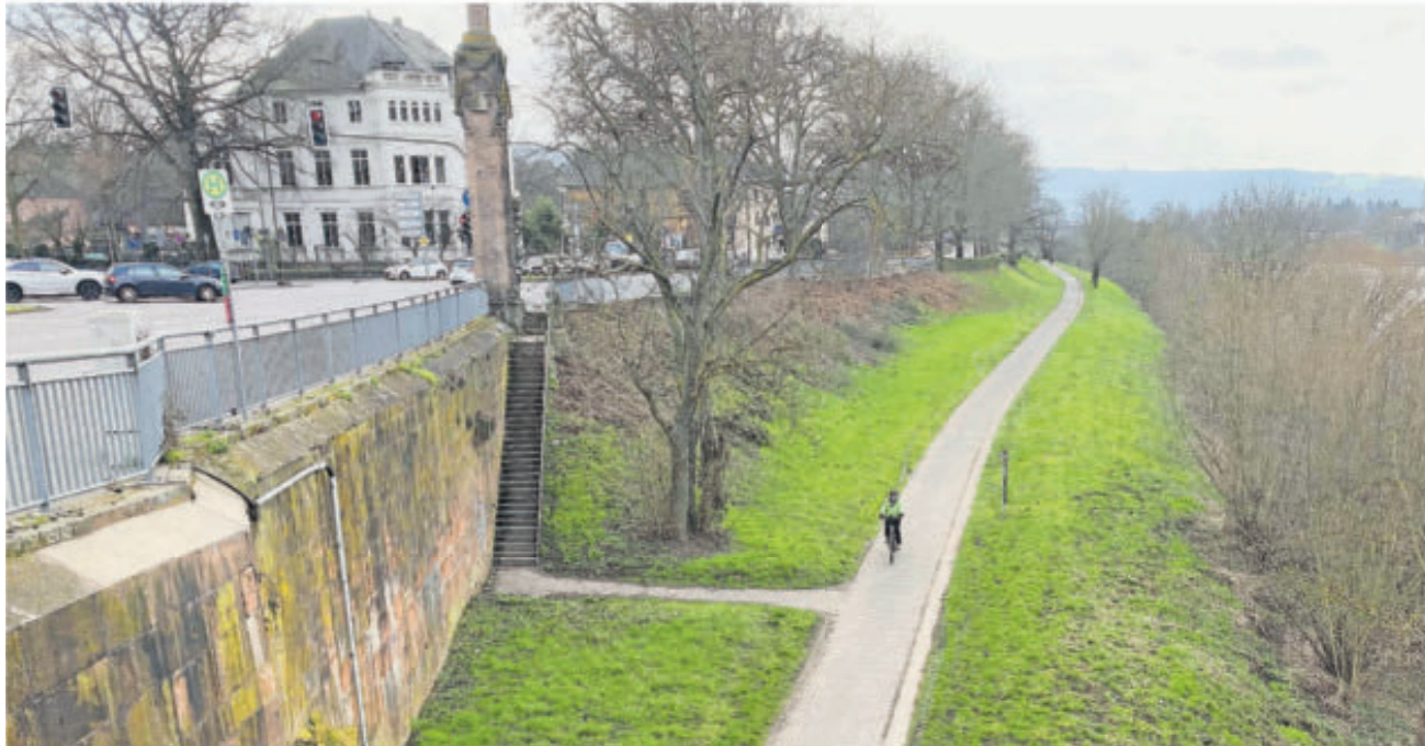
Der Radweg im Bereich Römerbrücke soll verbreitert werden. Noch in diesem Jahr.
