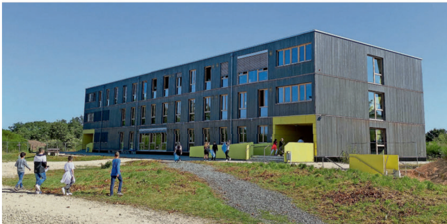
Bitter notwendig und heiß begehrt: die sogenannte Mobiskul, die derzeit auf dem Gelände der Integrierten Gesamtschule steht. Sie soll nach Abschluss der IGS-Sanierung am Standort Trier-West das neue Grundschulgebäude werden.
