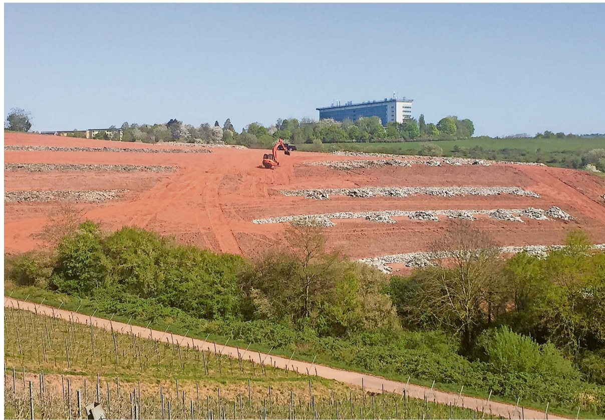
Markante Großbaustelle in den Olewiger Weinbergen. Hier entsteht eine neue Heimat für geschützte und gefährdete Tierarten.
