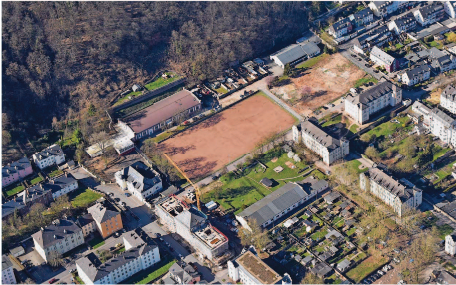
Im Herzen der denkmalgeschützten Gneisenaukaserne soll die neue Grundschule Trier-West entstehen. Bislang geplanter Standort ist der rechte Teil des derzeitigen Sportplatzes (Bildmitte). FOTO: PORTAFUG/FÖHREN
