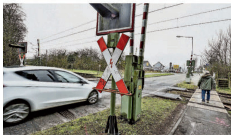
Funktioniert sie oder funktioniert sie nicht? Die Technik des Bahnübergangs in Trier-Euren arbeitet nicht immer zuverlässig. Das soll sich ändern.
