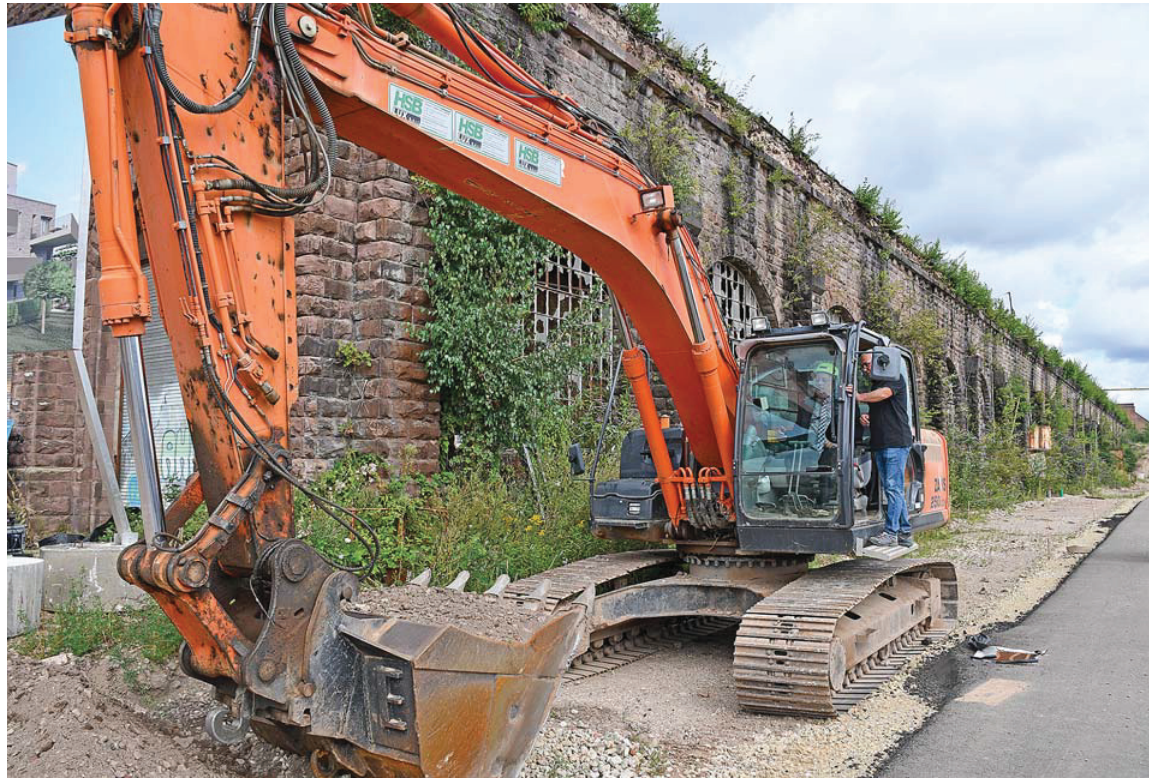
Bei der Arbeit. Baudezernent Andreas Ludwig läutet mit dem ersten Baggeraushub die heiße Phase für die Entwicklung der Industriebrache an der Lokrichthalle. Fotos: Presseamt/kg
