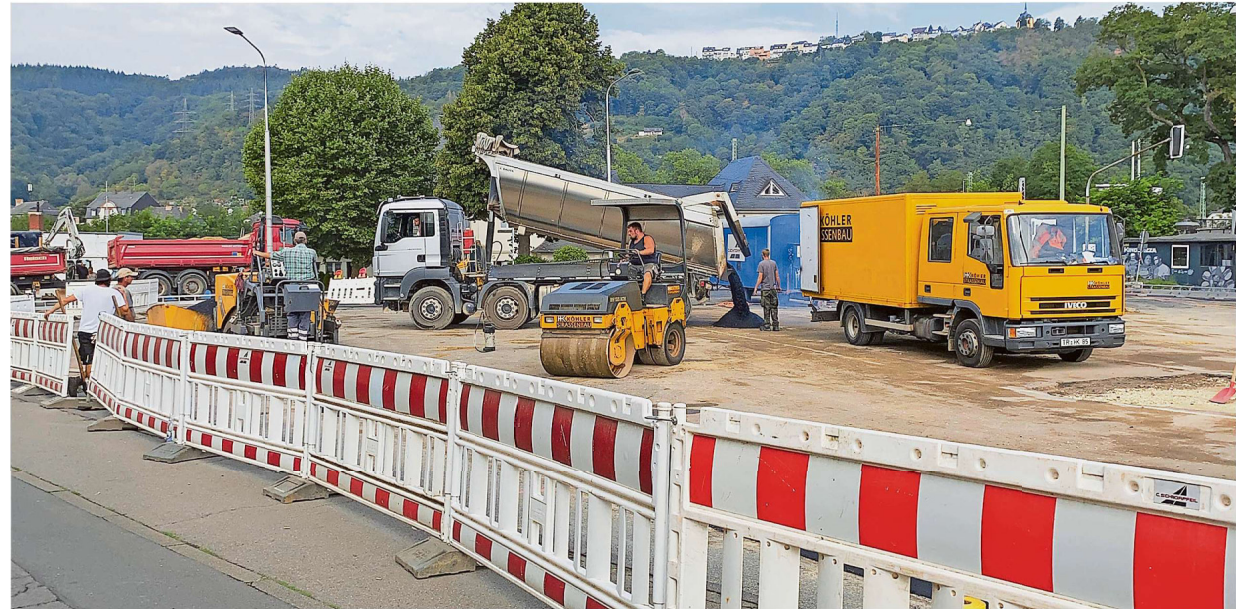
Die Arbeiten an der Römerbrücke schreiten voran. Ein neuer Bauabschnitt beginnt in der kommenden Woche. Die Verkehrsführung wird geändert. FOTO: RAINER NEUBERT
